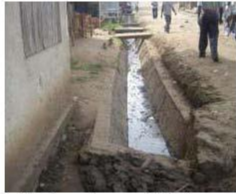
Situation du caniveau après les travaux de curage.
