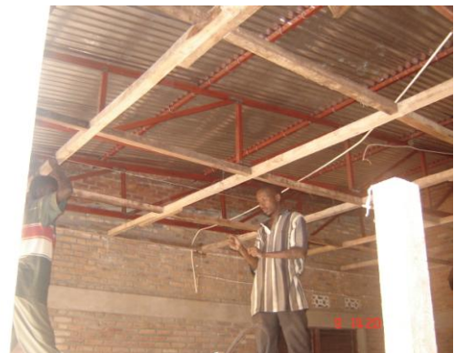
Travaux de réfection en cours
