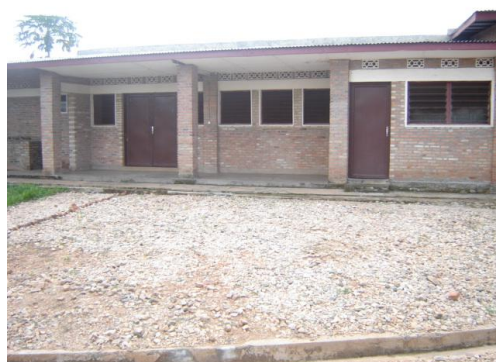
Bloc n° 2 construit avec le don de la Fondation du Cardinal Ersilio Tonini en 2003 + Clôture
