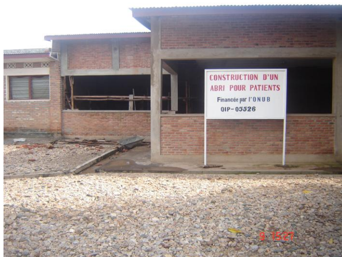
Travaux de réfection terminés
