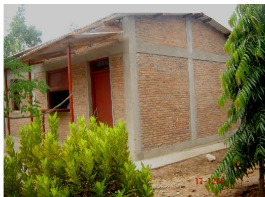
Construction terminée fin février 2008
